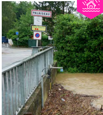
La station de mesure des débits de l'Yvette à côté du restaurant la Cabane encombrée en 2014. Credit @G_Thirel
